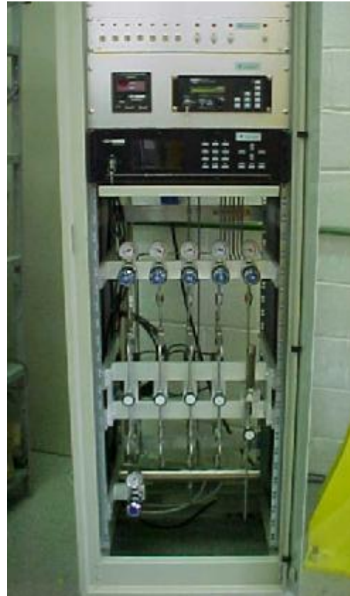
Figure 7. Consola de gases. Na parte superior observam-se os controles eletrônicos.
